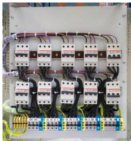
АС входная панель с выключателями / AC input panel with breakers
